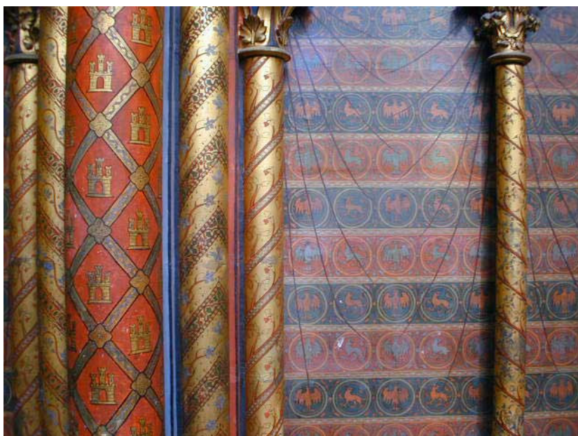
Fig. 54: Saint Chapelle, Paris. Detalhe da decoração colorida das paredes.
